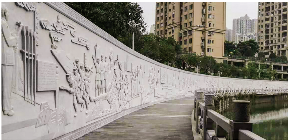
凤嘴江新武装部至南商广场段景观提升工程完工。
