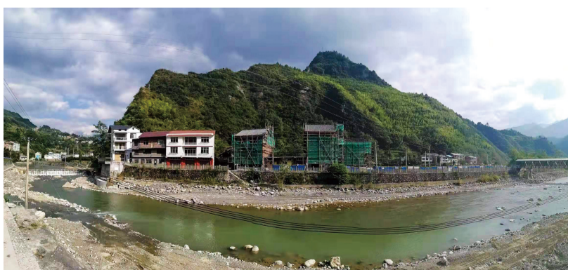
金山旅游小镇项目建设中。
